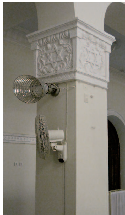
ΤΥΠΙΚΗ ΚΑΤΑΣΤΑΣΗ ΕΣΩΤΕΡΙΚΟΥ ΠΡΙΝ ΑΠΟ ΤΗΝ ΑΝΑΚΑΙΝΙΣΗ.
