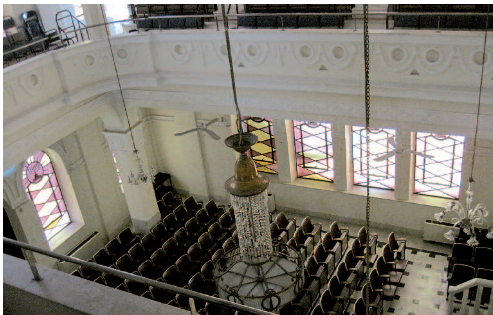
ΑΠΟΨΗ ΤΟΥ ΕΣΩΤΕΡΙΚΟΥ ΠΡΙΝ ΑΠΟ ΤΗΝ ΑΝΑΚΑΙΝΙΣΗ.
