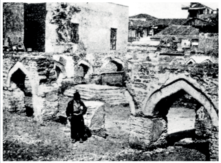
Ερείπια της συναγωγής Καταλάν μετά την πυρκαγιά του 1890 (Αρχειό Αβραάμ και Δαυίδ Ρεκανάτι - Αρχείο Ηλία Μεσσίνα) The ruins of Catalan synagogue after the fire of 1890 (Avraham and David Recanati collection - Elias Messinas archive)
